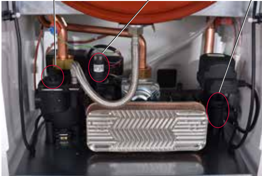
Клапан заполнения Сливной клапан
